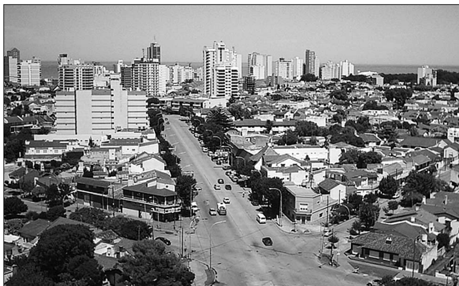
Vista de la ciudad de Necochea desde el edificio donde se instalará la antena.
