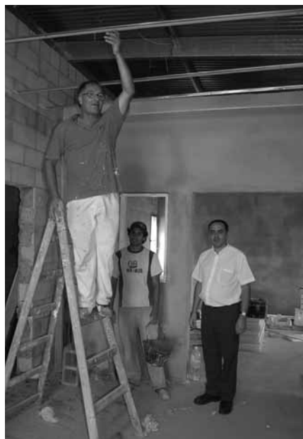
El Padre Juan Pérez recorriendo otro sector de la escuela, el cual aún está en obras.
